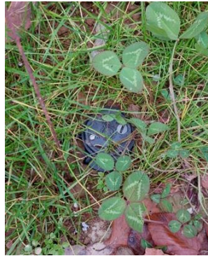
SLIKA 4: Zunanja enota namakalnega sistema.
