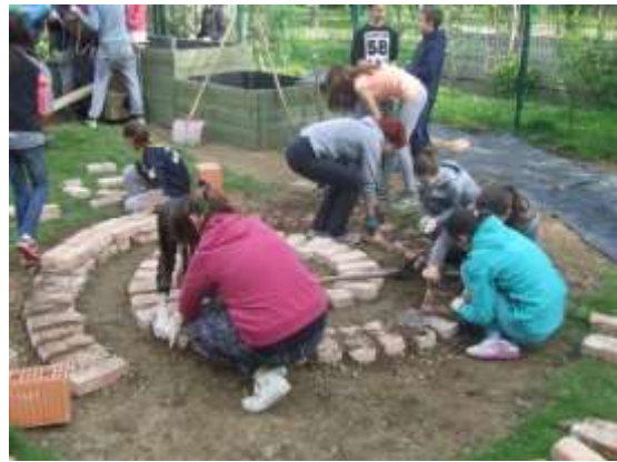
SLIKA 2: Gradnja spiralne grede.
