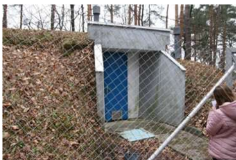
SLIKA 3: Vodohran v Grižah.
