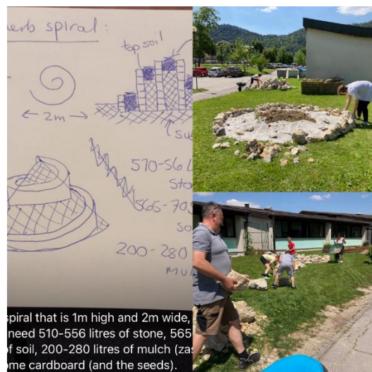
SLIKA 5: Zeliščna spirala. Od načrta do izvedbe.
