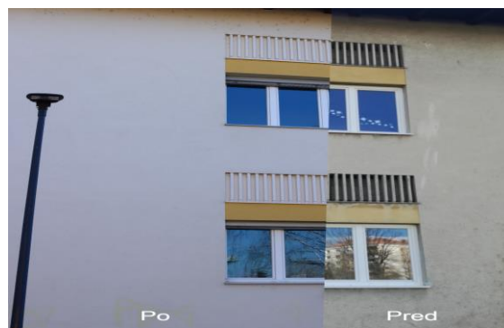
SLIKA 3: Primerjava izgleda fasade pred in po energetske sanaciji (vir: osebni arhiv)
